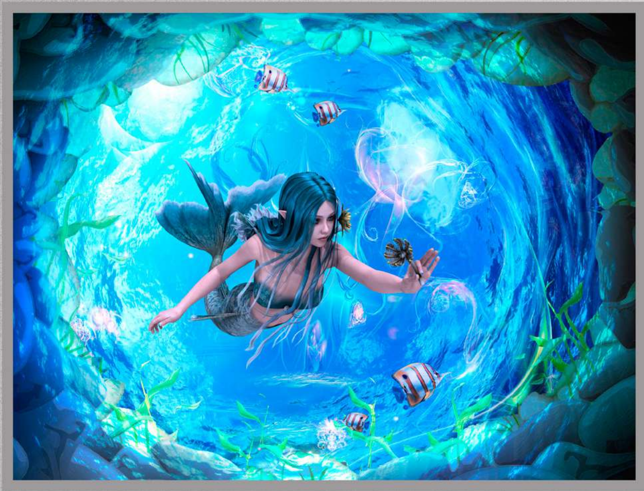
ОБЩИЙ ВИД ПОТОЛКА
